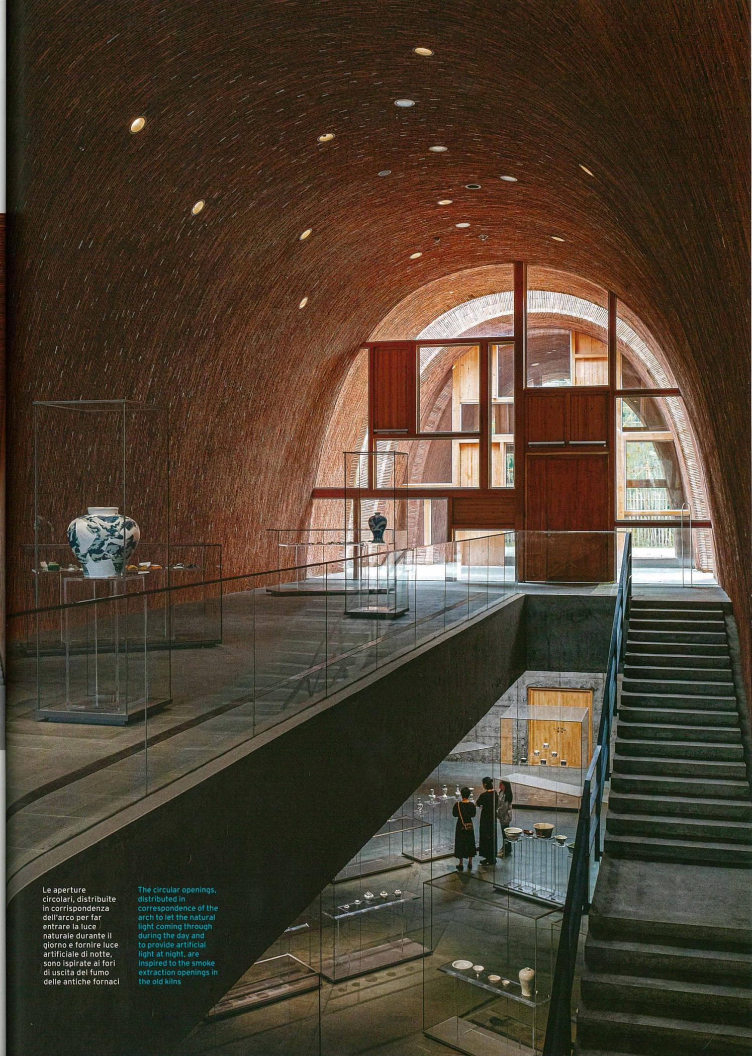
Le volte del museo sono state realizzate con una "struttura a sandwich": hanno un'anima in calcestruzzo armato, per resistere ai terremoti, rivestita da un mix di mattoni nuovi e mattoni riciclati, provenienti da forni distrutti
